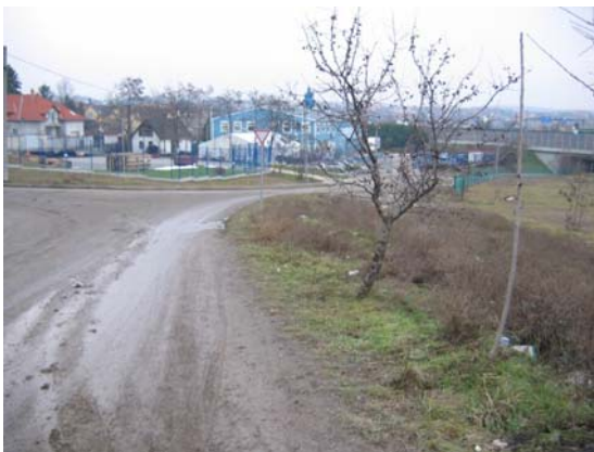
9. kép Az aluljáró északi oldala (Aszfaltozó utca)
