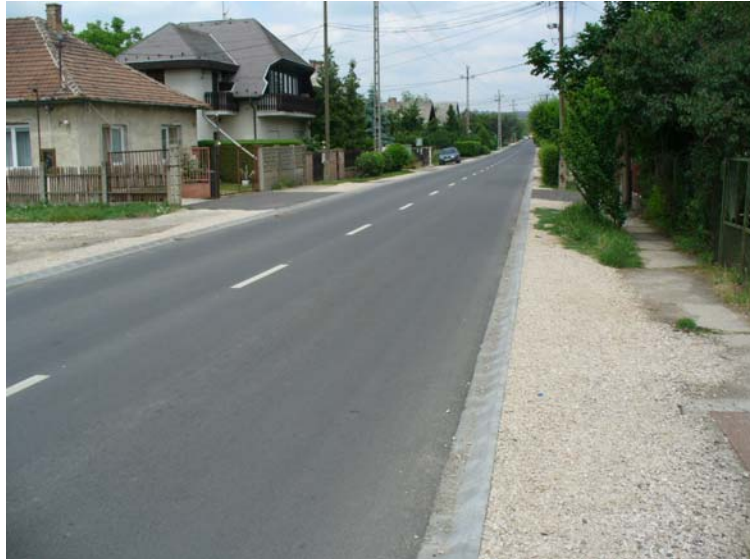
60. kép A felújított Bagoly utca
