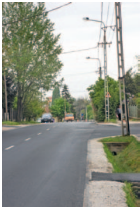
A DIÓSDI ÚT ÚJ ASZFALTBURKOLATOT KAPOTT, ÉS MEGÚJULT A CSAPADÉKVÍZ-ELVEZETŐ ÁROK IS.
