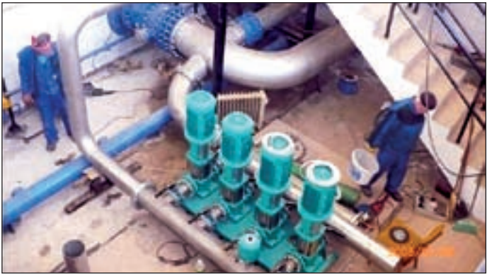
Sor került a gépházak teljes rekonstrukciójára
