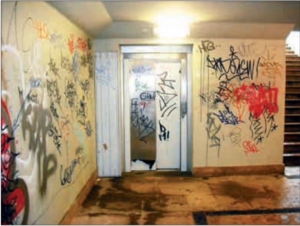
Lifteket a Diósdí úti gyalogos aluljárónál, még üzembe helyezés előtt – addig csak a vandálok „használták” őket
