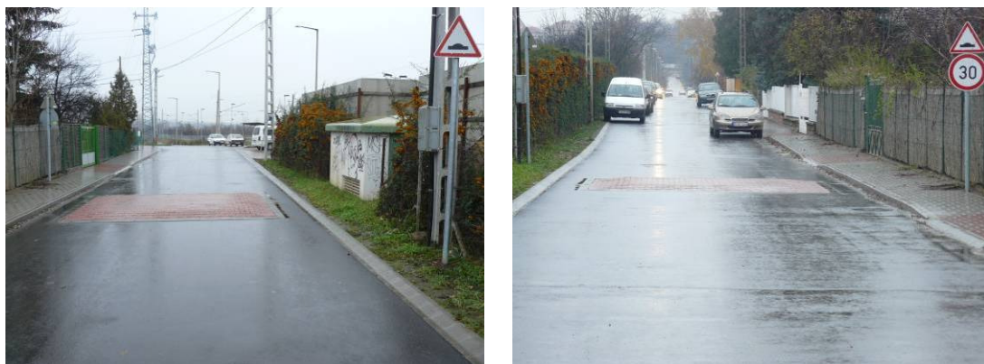
12. ábra A felújított Porcsinrózsa utca, fizikai sebességcsökkentéssel
