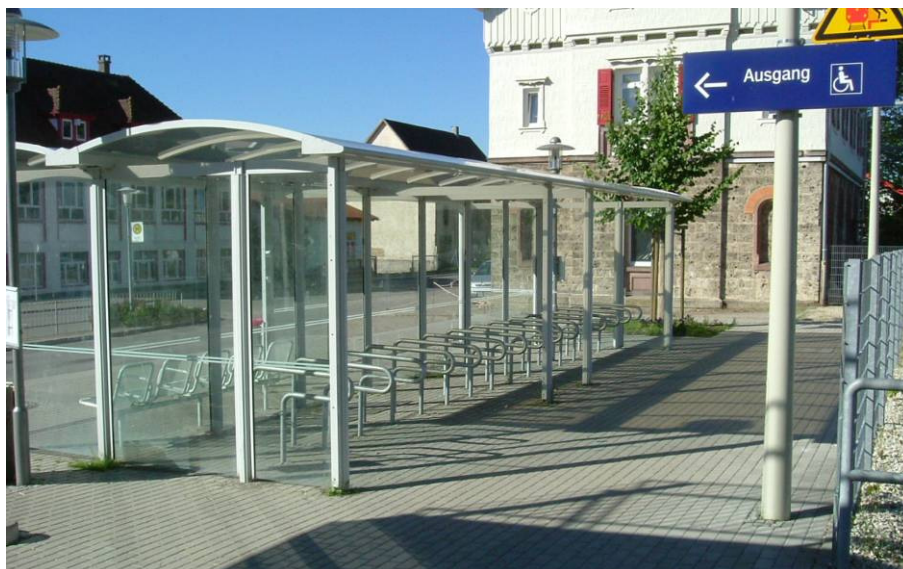
49. ábra Vasúti peron mellett elhelyezett B+R kerékpártároló Németországban
