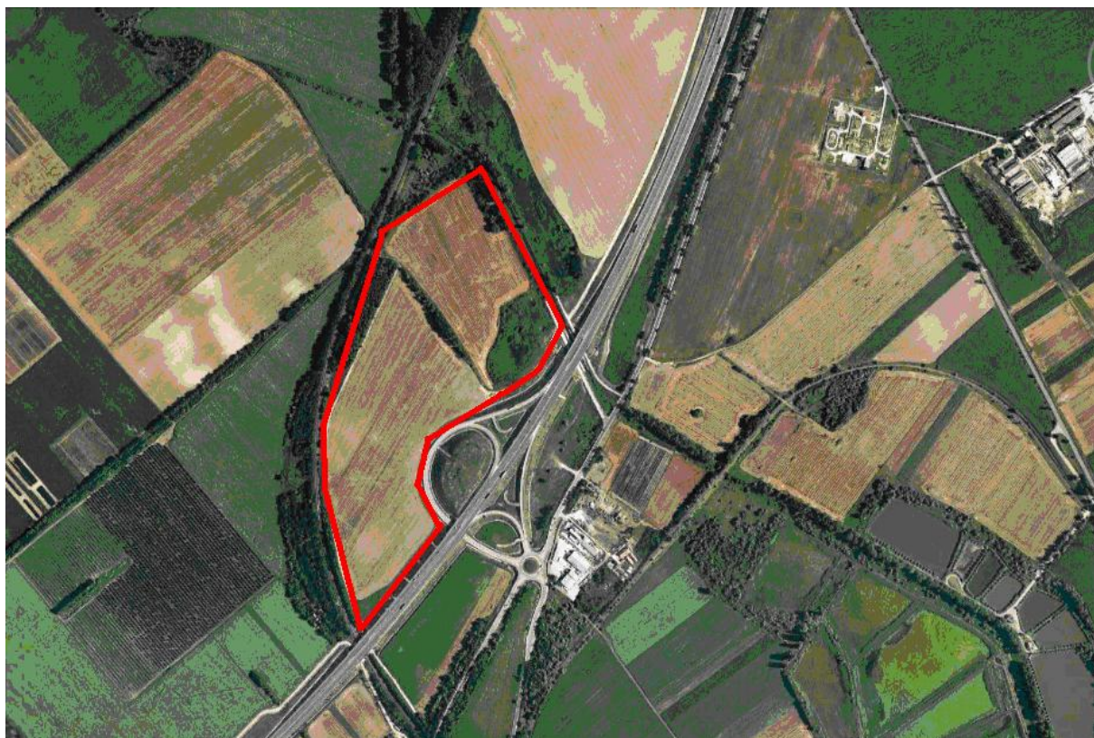
21. kép: Benta völgye (M6 Százhalombatta csomópont- vasút- Benta patak)
