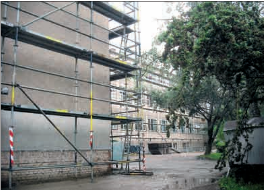
Új nyílászárókat, új külsőt kap a Széchenyi iskola
