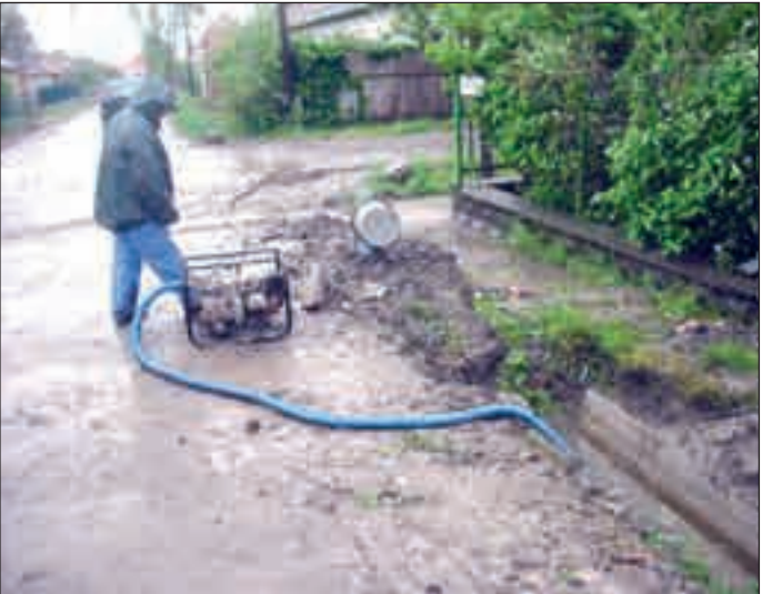
A RÁVNA-projekt egy készülő szakaszán átemelőt kellett üzembe helyezni vasárnap
