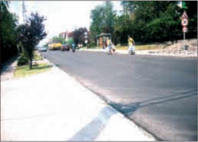
A Lőcsei út teljes útburkolata megújul: a teherhordó réteg már elkészült, a szegélyezést most készítik
