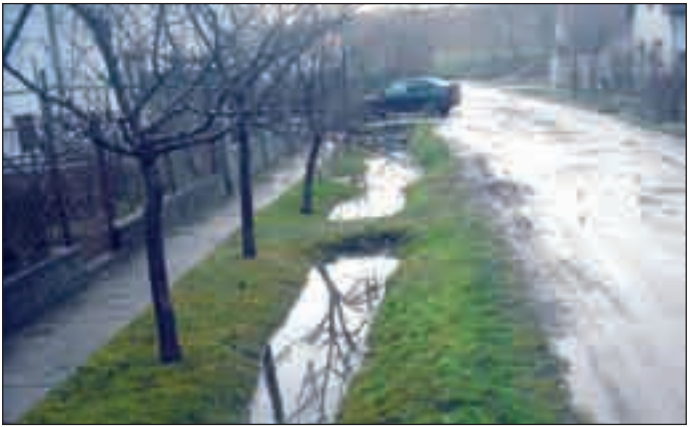
Ez a csatorna az utca két végén le van zárva, nincs hová folynia a víznek – amúgy sem tudna az áttereszek rossz állapota, a sok törmelék, nyese-dék miatt
