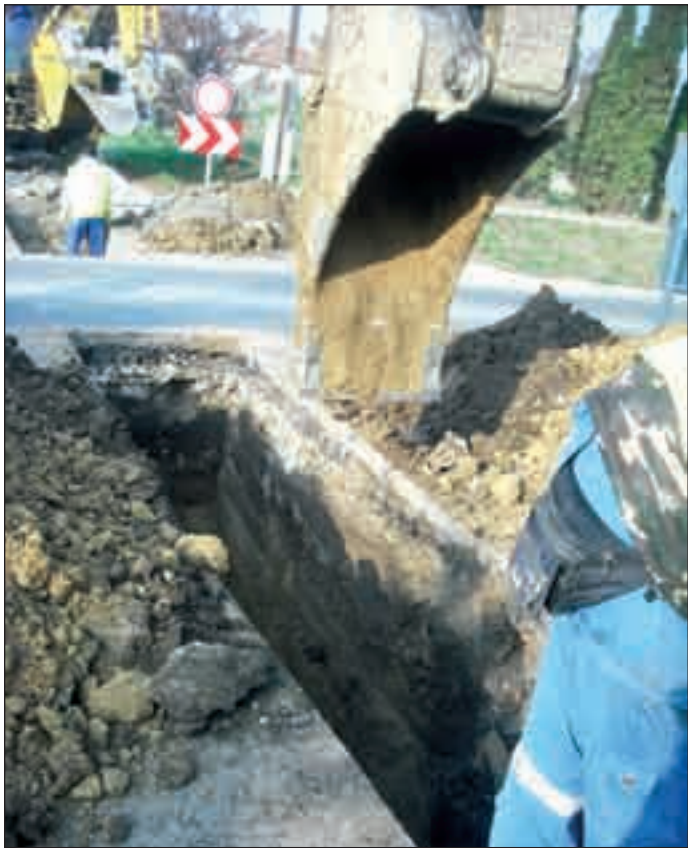
A munkagép két méter mély gödröket ás az úttest két oldalán. Körültekintően kell dolgozni, hiszen közművezetékek vannak a föld alatt
