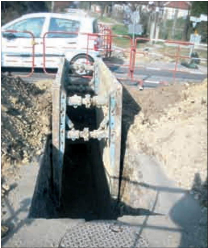
A kiásott árkok oldalfalát biztosítani kell az esetleges beomlás ellen
