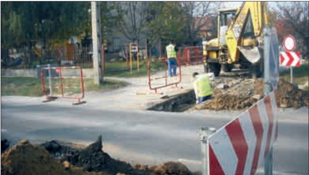
Útátfúrás a Kossuth Lajos utcában. E technikával úgy tudják lefektetni a csöveket, hogy a főútvonal forgalmát csak fél pályán kell lezárni
