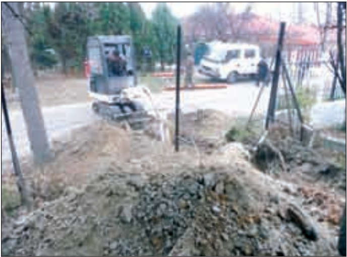
Markológéppel mélyítik az árkot a kerítés tövében
