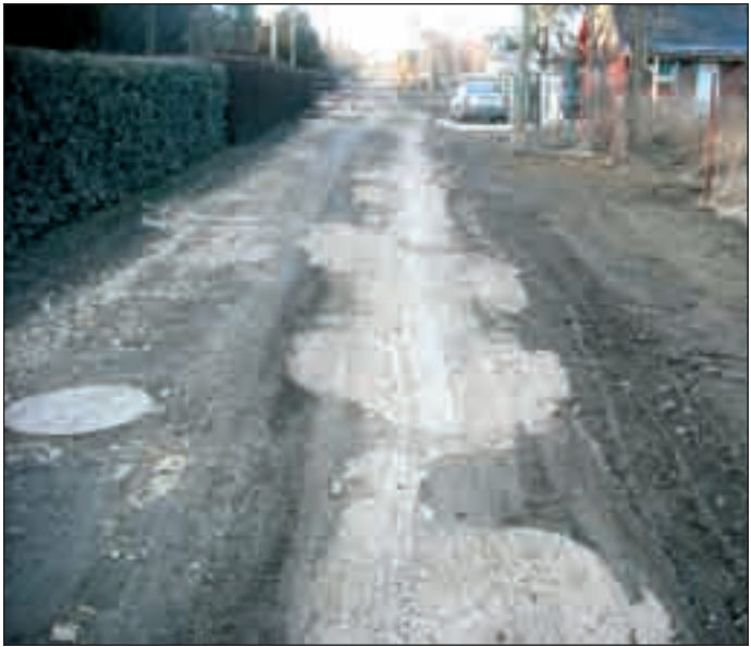
A már csatornázott utcákat járhatóvá teszik, de a végleges helyreállításra – a talaj süllyedése miatt – csak négy hónap múltán kerülhet sor
