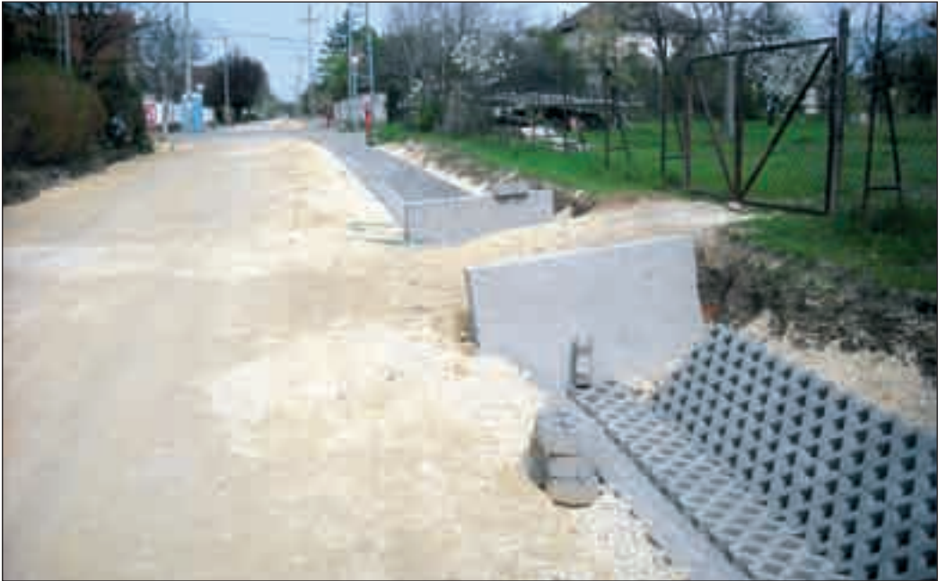
Nemcsak a csatorna épül, hanem a szervízutak is – képkönn az Arany János utca
