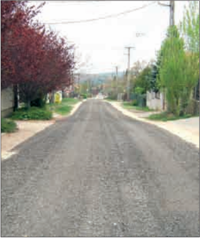
A Betonozó utcában elkészült a mart aszfaltos útburkolat
