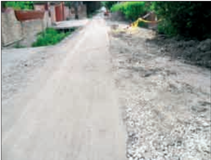
A csatornacső fektetése után a végleges helyreállítás több hónappal a csatornacső-fektetés után történik meg
