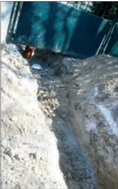
Amint bent van a csomak, kezdődhet a belső vezeték kiépítése
