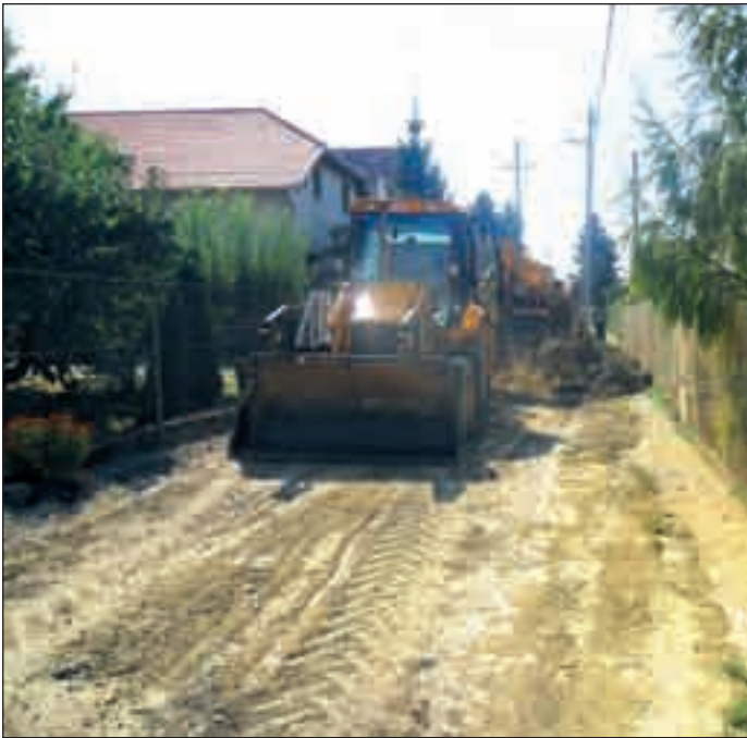
Amikor az ingatlan előtti csatornaszakasz üzembe helyezéséhez megvan minden hatósági jóváhagyás, csak akkor, a rákötési engedély birtokában köthetnek rá a hálózatra az ingatlan tulajdonosok
