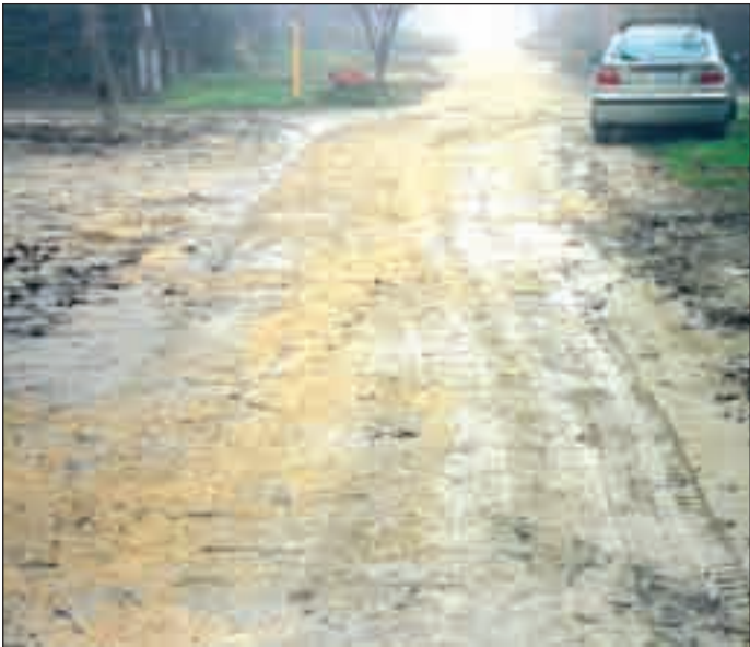
Az ideiglenesen helyreállított utca néhol nehezen járható
