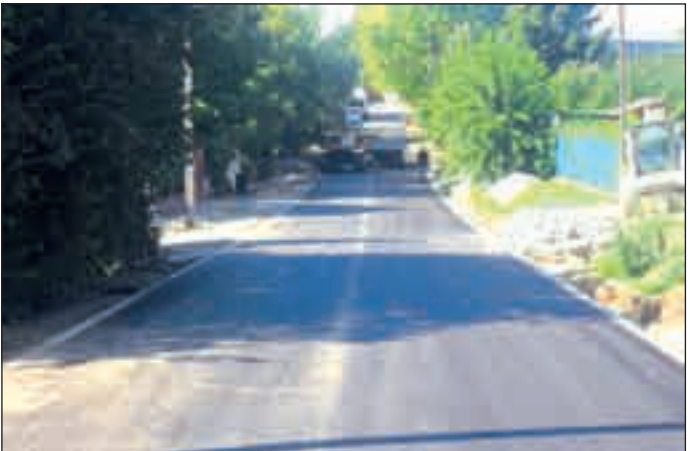
A Retyezáti utca újabb szakasza épült meg
