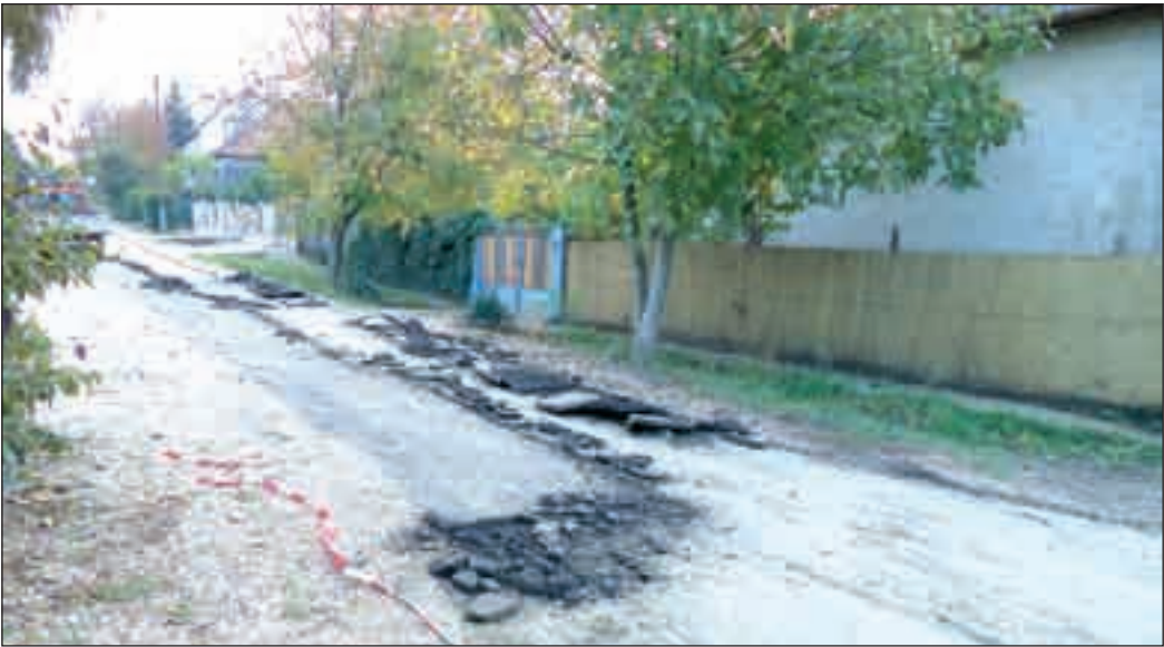
T. Mészáros András reméli: a csatornafektetést követő úthelyreállítások befejeződnek még a rossz idő beállta előtt
