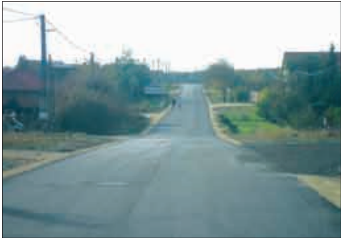
A Sós-kúti út egészen a Zengő utcáig megfelelő helyreállítást kapott
