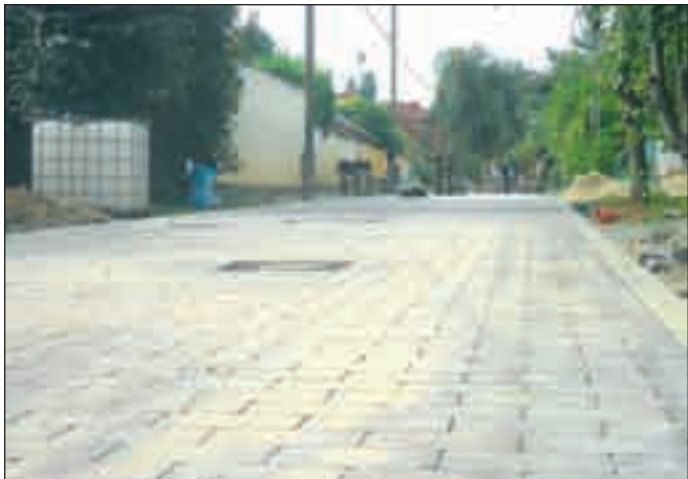
A Bolyai iskola környékén az új útépítési technológiát is kipróbálták – remélhetőleg a jövőben sok ilyen utca fog épülni Érden
