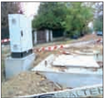
Épülő átemelő a Könyves Kálmán utca elején - december közepén indulhat a próbaüzem
