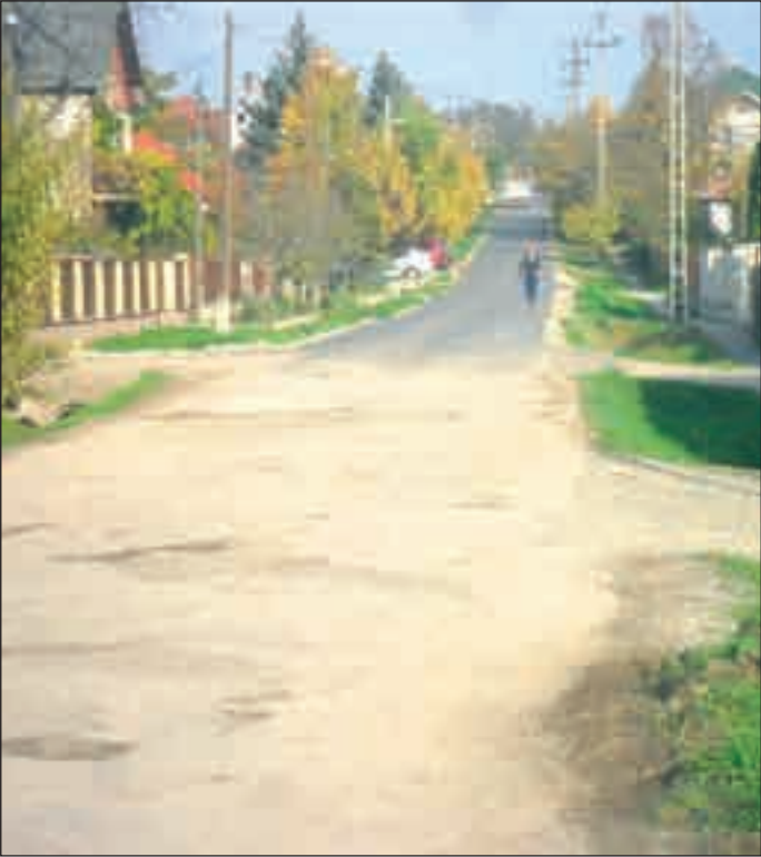
Csatornaépítéssel érintett és nem érintett utcaszakaszok a Béla utcában - ahol volt csatornaépítés, ott már helyreállították
