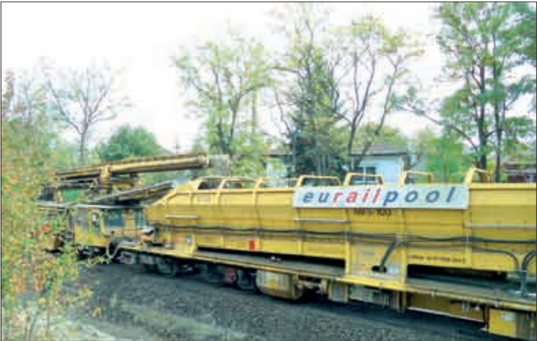
A vasút-rekonstrukciónak köszönhetően gyorsabban és gyakrabban járhatnak a vonatok Budapest és Érd között. Képünkön az Érd Felső és Tárnok közti szakasz átépítése látható
