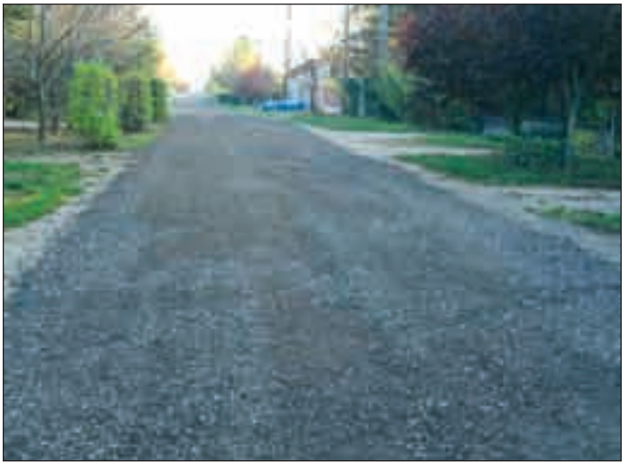
A Fényező utcában mart aszfalttal állították helyre – két másik hosszú utcát a környéken aszfalttal erősítettek meg
