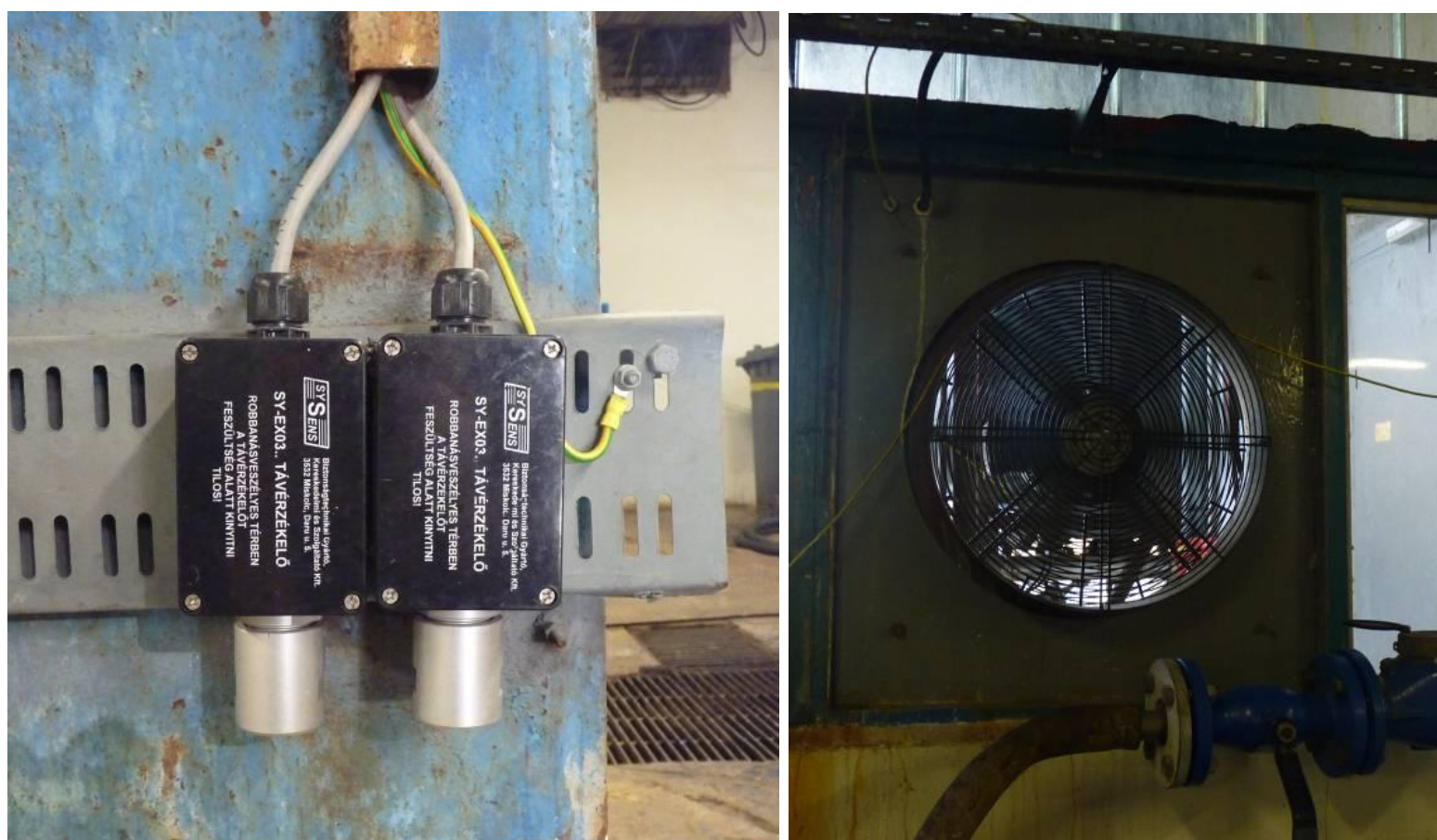
Gázérzékelő berendezés a földszinten és az automata ventillátor
