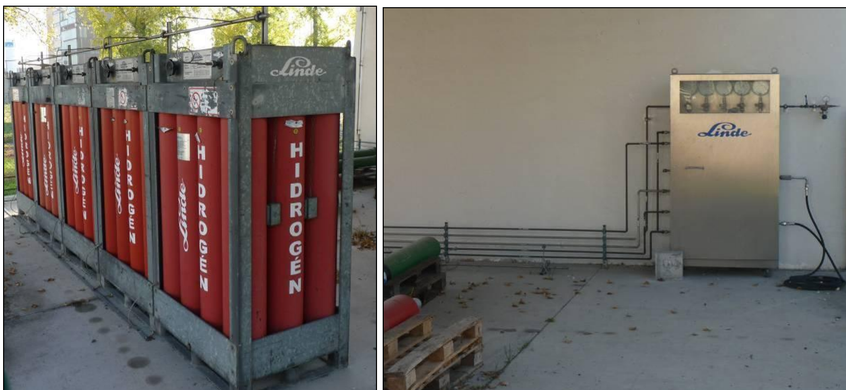
Hidrogéntároló bündelsor és a lefejtő/töltőegység
