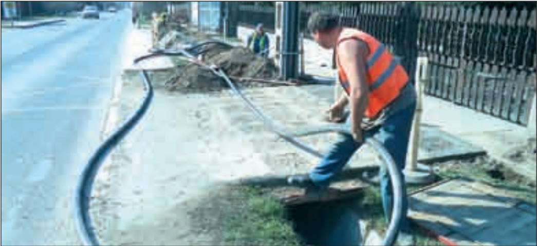
Köztéri átemelő áramkábelt fektetik a Kossuth Lajos utcában február végén
