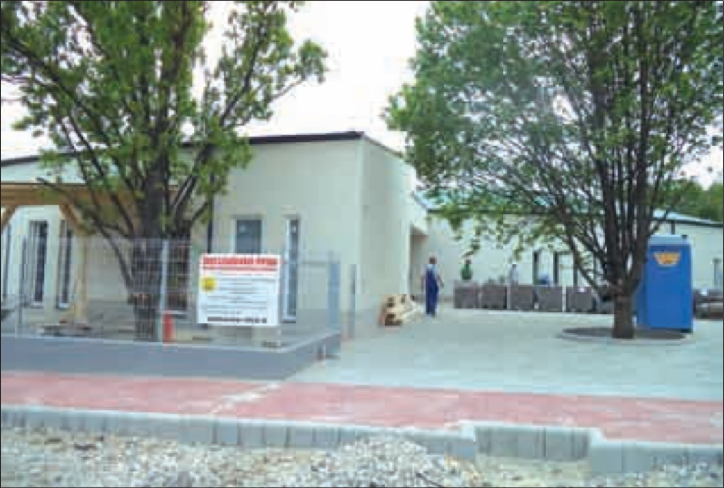
Hamatosan befejeződnek a Meseház Óvoda külső munkálatai
