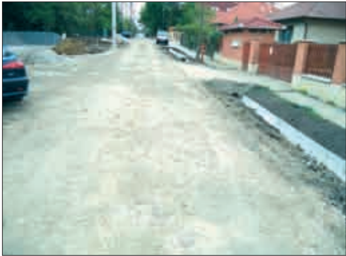
A vízelvezető rendszer kiépítése már megkezdődött, hamarosan a téglaköves burkolás is megtörténik
