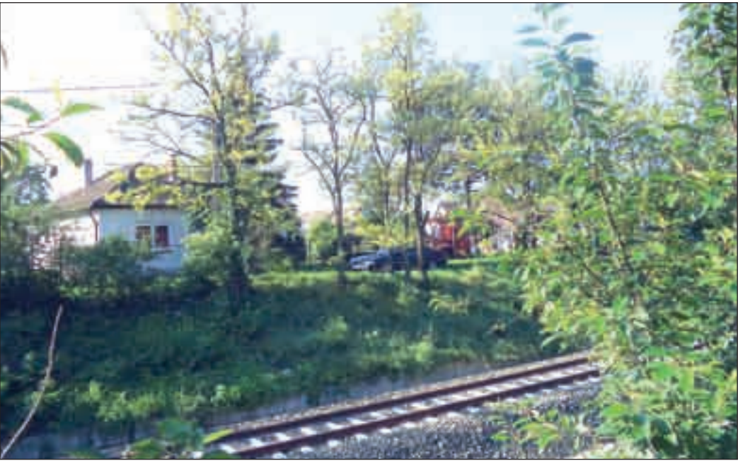
Hamarosan indulhat a nagy projektből kimaradt utcák csatornázása - ilyen a Rákóczi utca két vasút közti szakasza is
