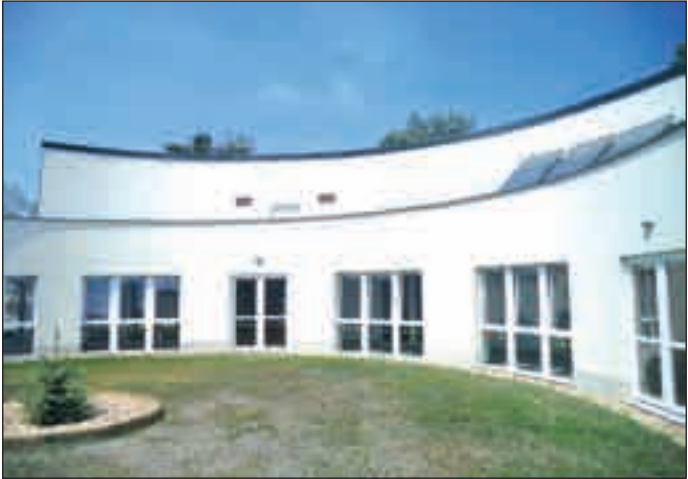
Az épület melegvíz-ellátására a tetőn elhelyezkedő napelemek is rásegítenek
