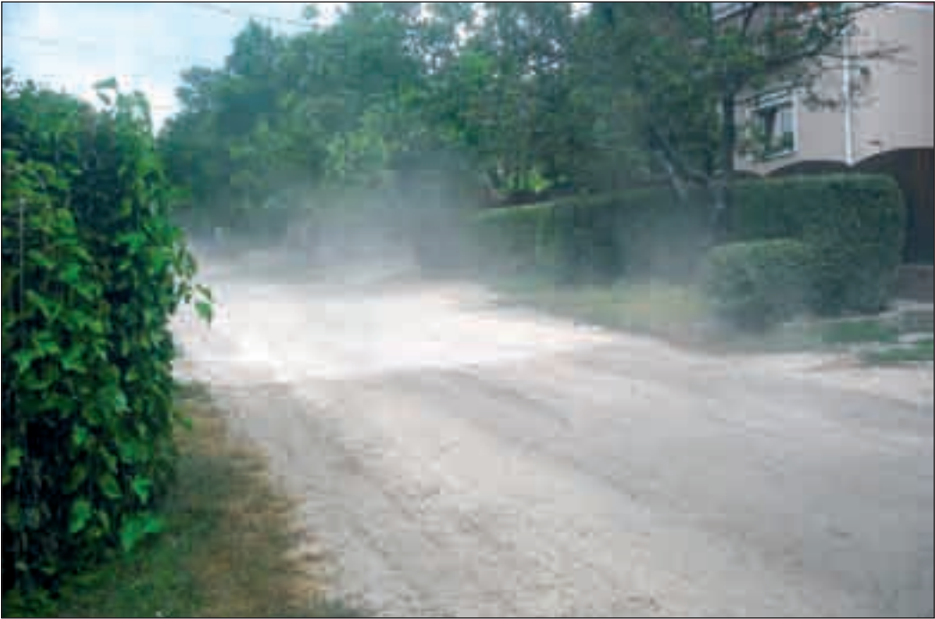
A kalcium-kloridos locsolás hatása - látható, hogy csak az út kezeletlen fele porzik
