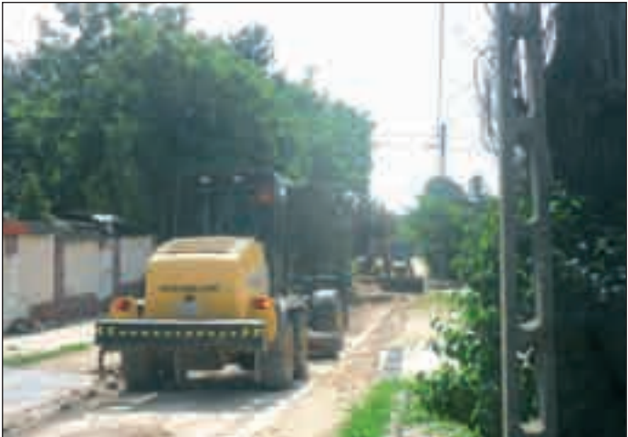
Dolgoznak a munkagépek a Takács utcában, előkészítik az aljzatot a bitumenezésre
