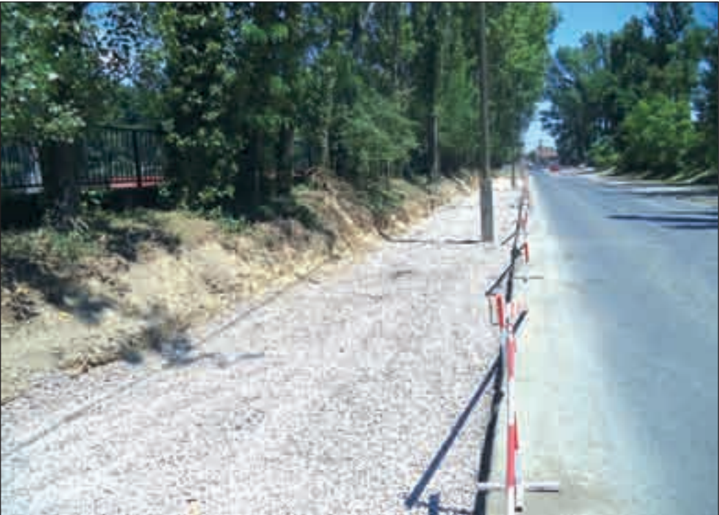
Épülnek a parkolóhelyek a Bethlen utcában, Érd felső vasútállomás közelében
