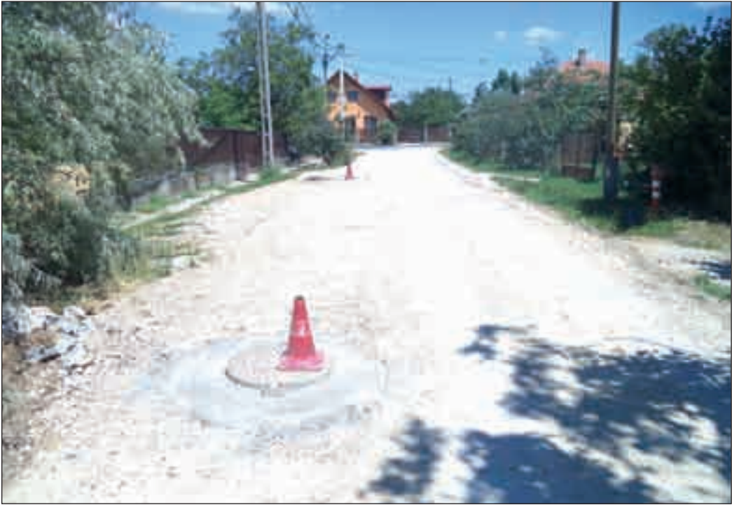
A Ferenc utcában is megkezdődtek az előkészítő munkálatok
