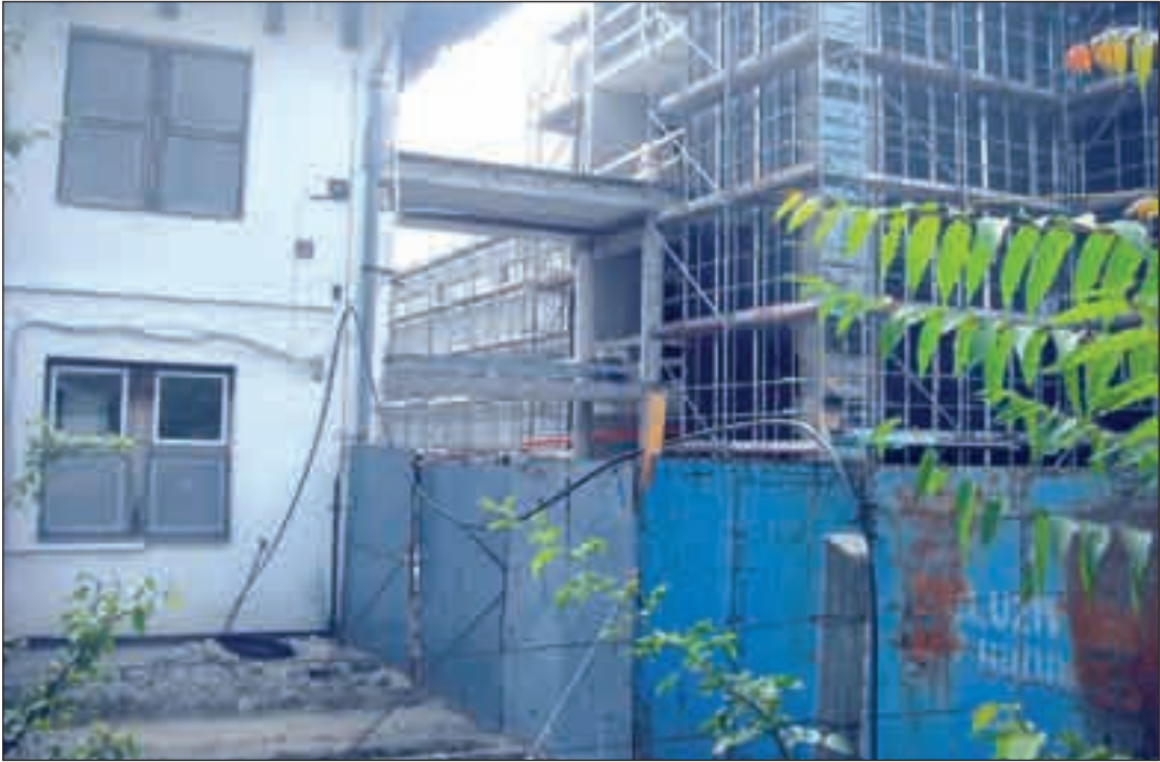
Az elmúlt évek egyik legfontosabb fejlesztése a szakrendelő átépítése, bővítése volt - képzünk csaknem négy éve készült
