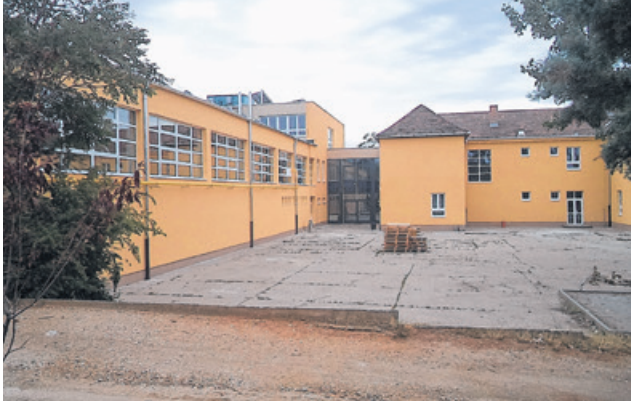
Három hónap alatt sikerült befejezni a felújítási munkát a Telekiben
