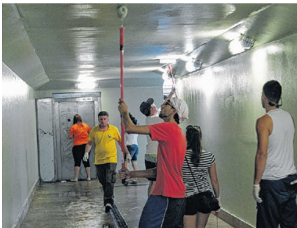
Halványzöldre festették a falakat és a mennyezetet, megtisztították a liftajtókat, lemásozták a korlátokat
