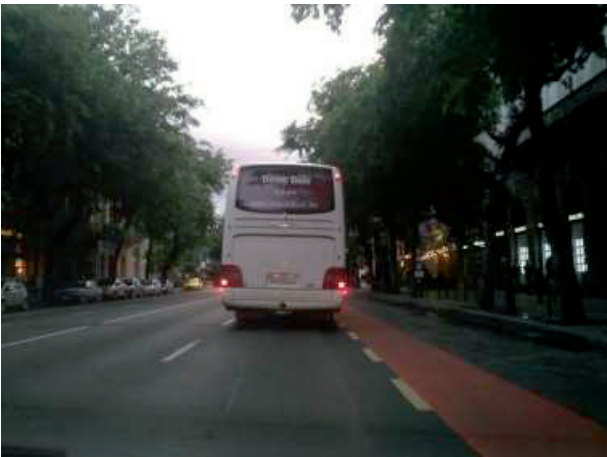
76. ábra – Szűkített forgalmi sávok (2,75 m) kialakítása mellett jutott hely kerékpársávnak is (Budapest, Andrassy út)
