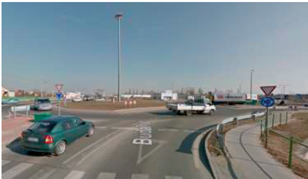
47. ábra – Budai út – Balatoni út turbó körforgalom Gyalogosan és kerékpárral is nehéz az átjutás (kerékpárosoknak a Budafoki és a Balatoni út felé ráadásul tiltott is a táblák szerint, de ez csak a körforgalom után derül ki számukra).
