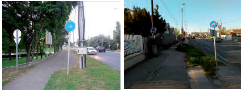
25. ábra – Balatoni úti kerékpárút a Fürdő utcánál és a Diósd felőli végén Leromló állapot és hiányzó, balesetveszélyes továbbvezetés, nem egységes táblázás.
