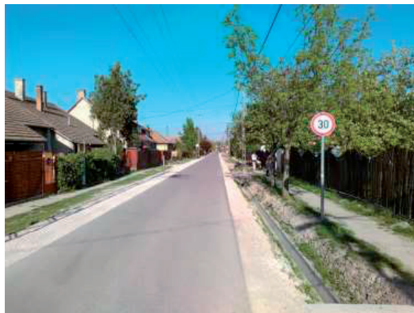
35. ábra – Sárd utca, a szerkezeti terv szerint tervezett gyűjtőút, funkciója már ma is ez Új 3,50 m-es burkolatszélesség, széles murvás padka és nyílt árok, 30-as sebességkorlátozás.
