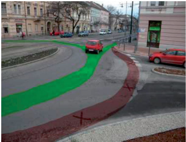
92. ábra – A kerékpárosok átvezetésének biztonságos nyomvonala körforgalomban 31
