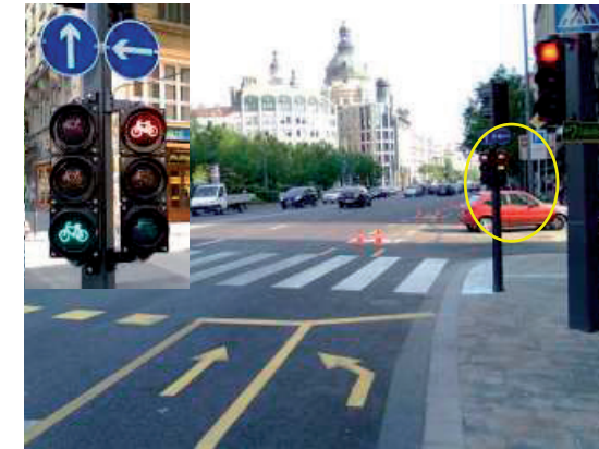
88. ábra - Közvetett (indirekt) balra kanyarodó felállóhely és jelzőlámpás jelzése (Budapest)
