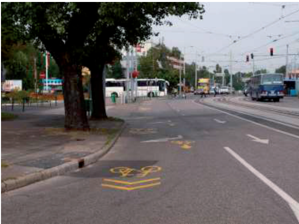
83. ábra – Példa kerékpáros nyom alkalmazására (Budapest)
