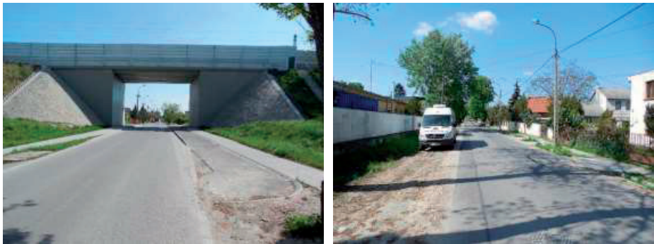
29. ábra – Duna utcai vasúti felüljáró alatt létrehozott felület. A kialakítás a belterületen kevésbé javasolható önálló kerékpárút átvezetésére készült, amelynek továbbvezetésére sem lenne hely.
