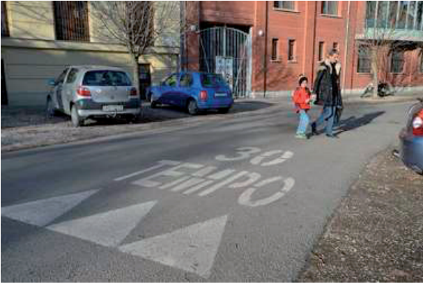
98. ábra: 30 km/h-s övezet bejáratí burkolatfestése Szegeden 34 Kiegészíthető forgalomlassító küszöbvel, burkolatszínézéssel is
