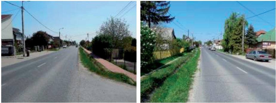
32. ábra – A Bajcsy-Zsilinszky út jellemző keresztmetszeti kialakítása 6-6,5 m-es burkolatszélesség, kapubejárók, bolt előtti parkolók és nyílt árkok a jellemzők.
