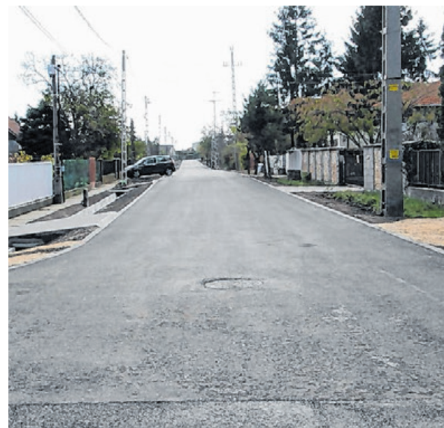
Alsóerdő utca a csatornázás után
