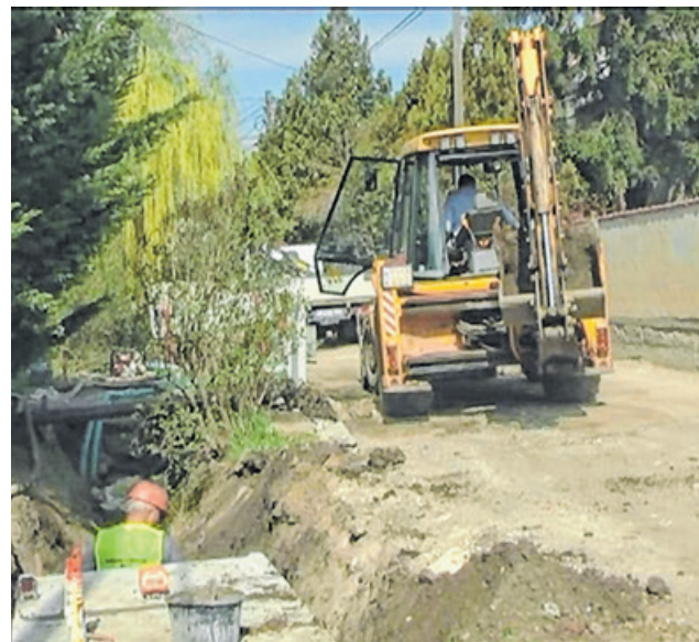
A Fürdő utcában a csapadékvíz-rendezés után szilárd burkolat lesz
