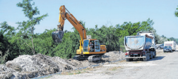
A Tárnoki út két ütemben újul meg: először a vízelvezető rendszert építik ki, ezt követi az aszfaltozás
