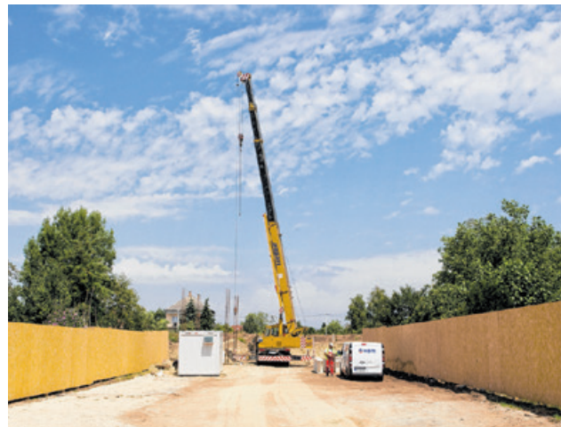
Szeptemberben lesznek látványosabb szakaszok: megkezdik a híd alapépítményének felhúzását és beemelik az acélfőtartókat
