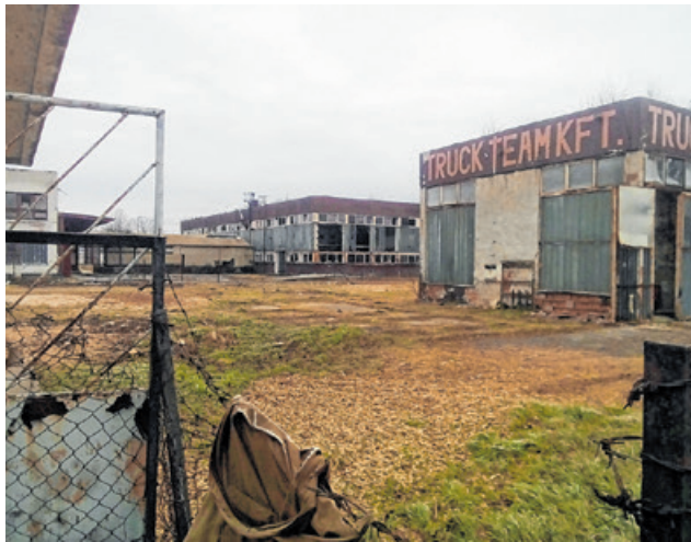
A Micsurin szörpüzem épülete ma
