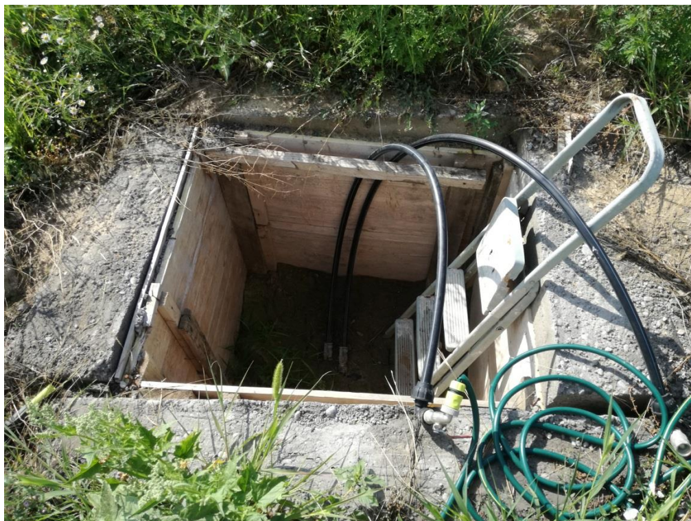
27. ábra: a telken végigmenő, ~600 m vízvezeték szerelőaknája
