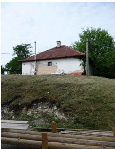
A Szilfa utcai épület nézete észak felől
