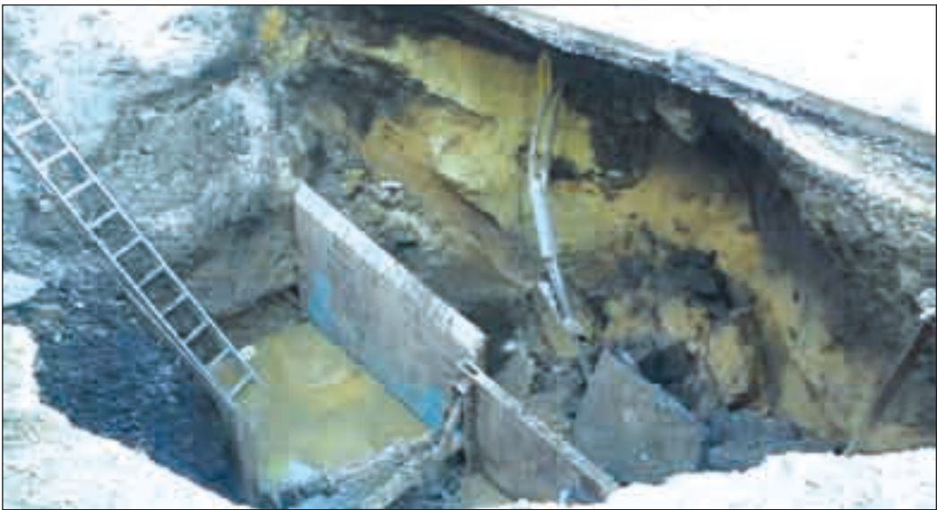
A meghibásodott vezeték mélyen fut, és nem szenny-, hanem csapadékvizet szállít - a csőtörés a házakat nem veszélyeztette
