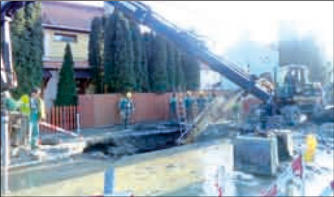
Az ÉKFI munkatársai 50-60 köbméter átázott földet termeltek ki, és műanyaggal pótolták a szétmállott betoncsövet (képeink múlt szerdán készültek)
