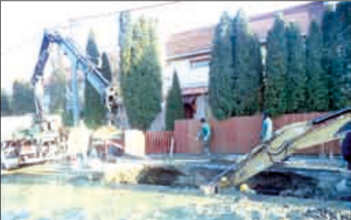
A meghibásodott vezeték mélyen fut, és nem szenny-, hanem csapadékvizet szállít - a csőtörés a házakat nem veszélyeztette
