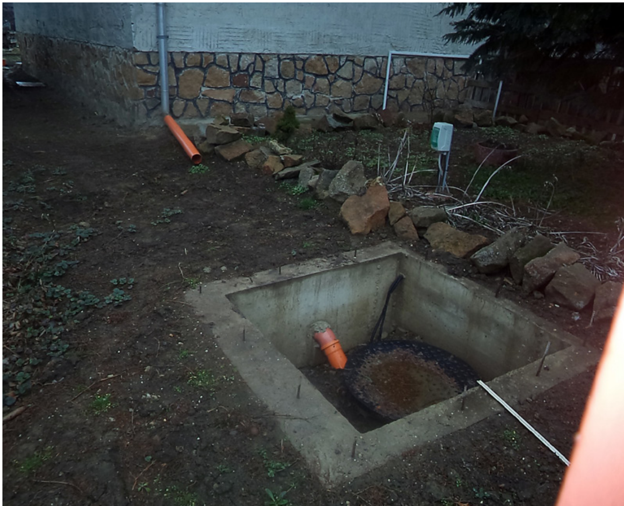
Indul a házi átemelők telepítése
