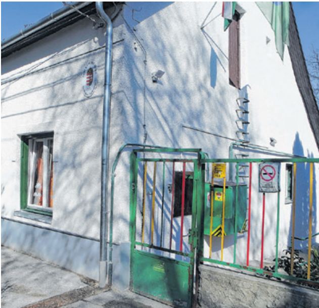
A Tündérvkert óvoda villamosenergia-hálózatának rekonstrukciója során a nyári szünetben kerül sor
