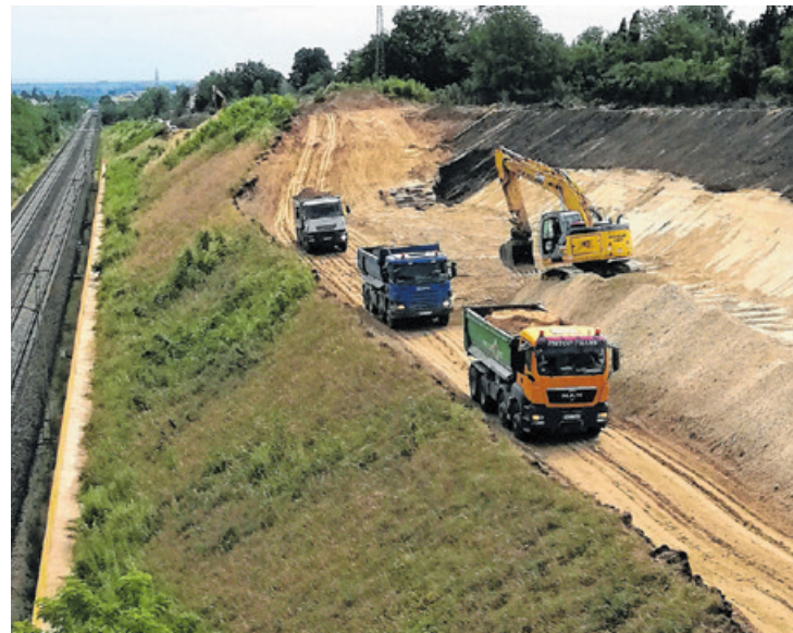
A bontott törmeléket tehergépjárművekkel szállítják el, a beruházó NIF Zrt. az érintettek észrevételeit is figyelembe veszi (Fotó: ErdTV/Archív)
