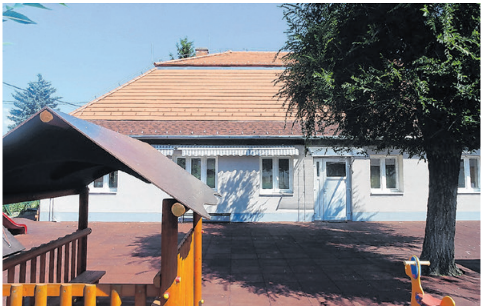
Tavaly kezdődött, idén fejeződött be a Tállya utcai óvoda teljes felújítása
