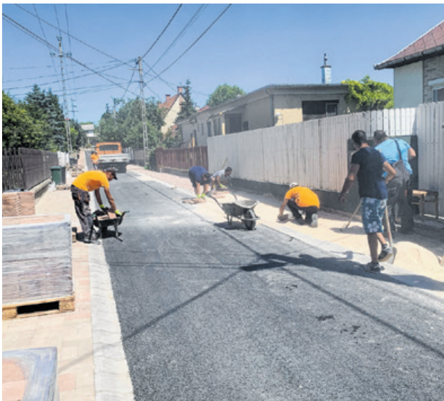
Az aszfaltozást követően már a járda munkálatait végezte a kivi-telező
