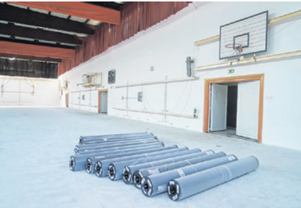
A betont már előkészítették a parkettázáshoz, a falakat javították, újrafestették
