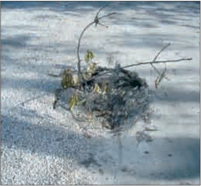
A csatornázás során a leggyakoribb hiba a nem megfelelő tömörítés, ezért fordulhatnak elő megsüllyedt, beszakadt utak
