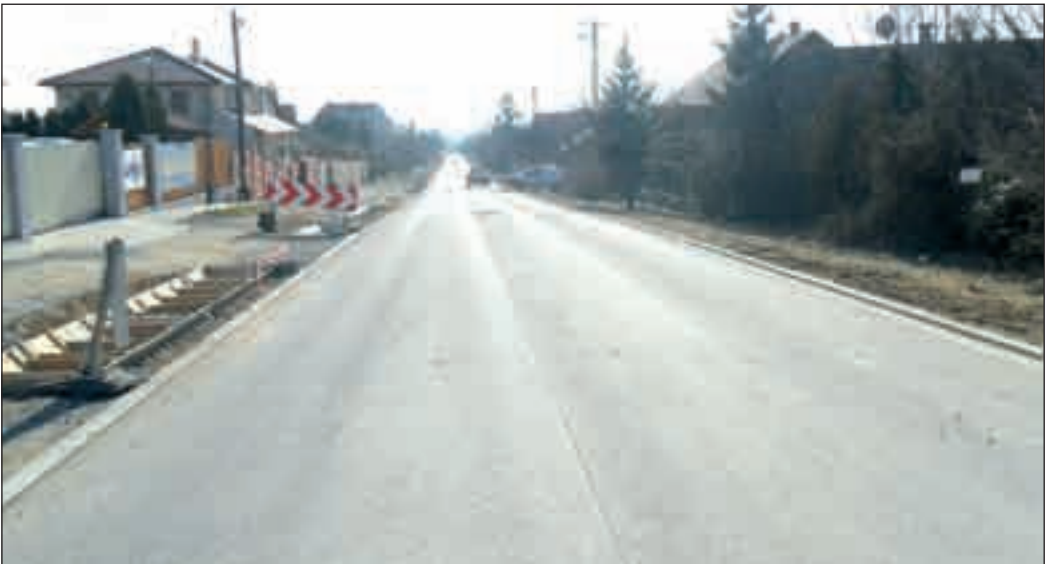
Kalotaszegi utca – Az árkok befejezése után rákerül a kopóréteg, és máris készen van a régóta várt út
