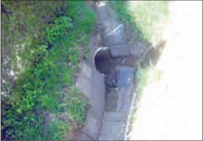
Ez a szelíden csörgedező vízfolyás nagy esők után felbuzog és elönti a kertet – mint a képen is látszik: a bevezető csatorna átmérője jóval nagyobb a kivezetőénél
