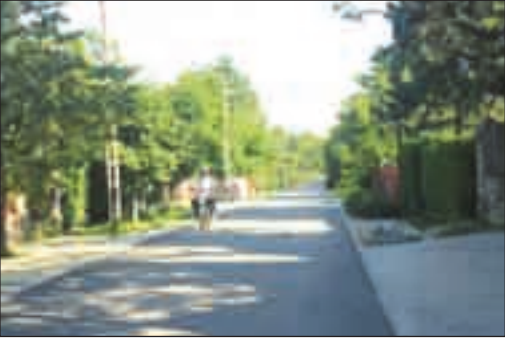
A Földmunkás utca új aszfaltburkolatát kezdik megszokni a környék lakói
